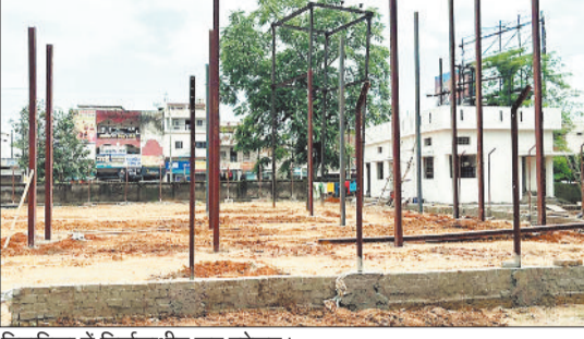
निहारिका में निर्माणाधीन सब स्टेशन।
